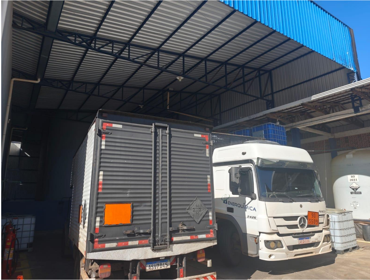
FIGURA 3 – Vista geral da estrutura metálica
